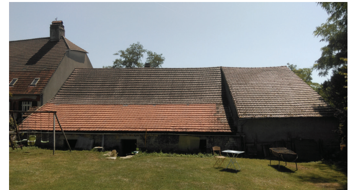
Façade et toiture d'origine
