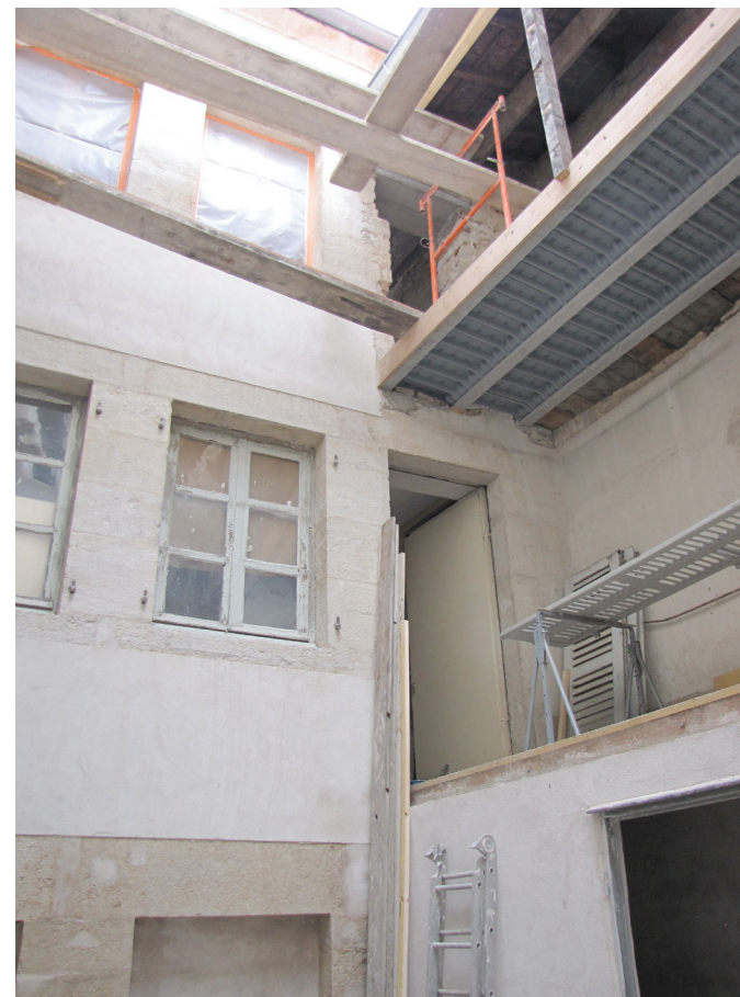
État de la cour intérieure en cours de rénovation
