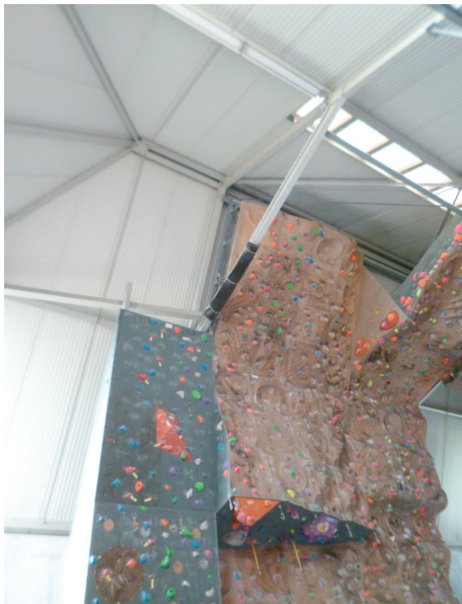
Ancien mur en panneaux de fibre
