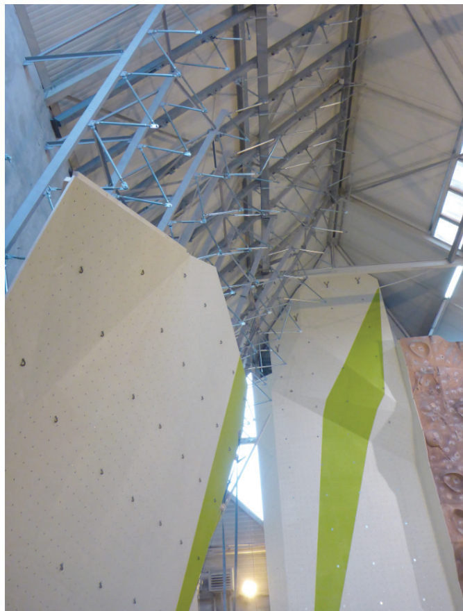
Nouveau mur en cours de réalisation
