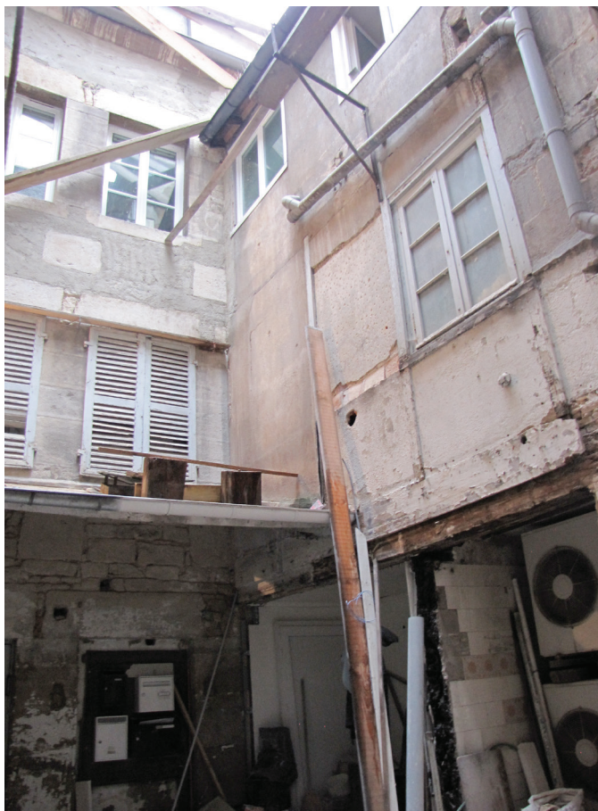
État initial de la cour intérieure
