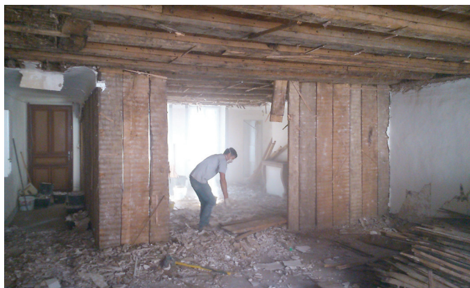
Travaux salon salle à manger d'origine
