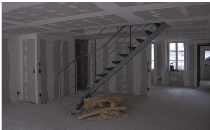
Salon salle à manger, escalier pendant travaux
