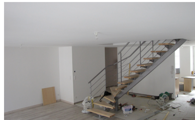
Salon salle à manger, escalier actuel
